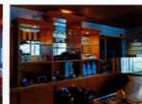
Tresen mit Zapf-Anlage und großen Kühlschubladen
